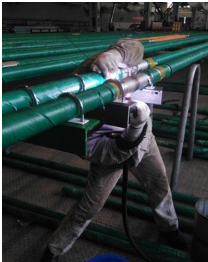
图 6 焊接不锈钢管子
