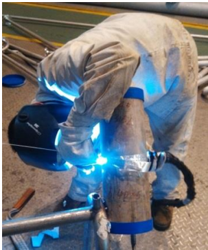
图 2 焊接不锈钢管子
