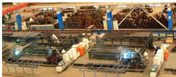
图12 江南管业车间管子-法兰自动焊接生产线
