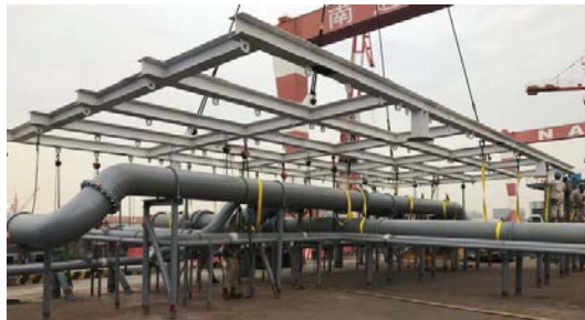
图 3 单元通过吊梁进行吊装
