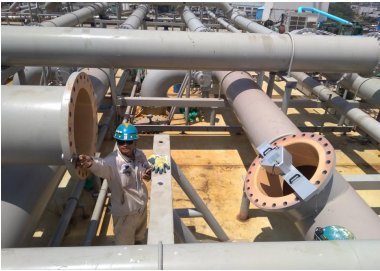
图 4 合拢管现场测量
