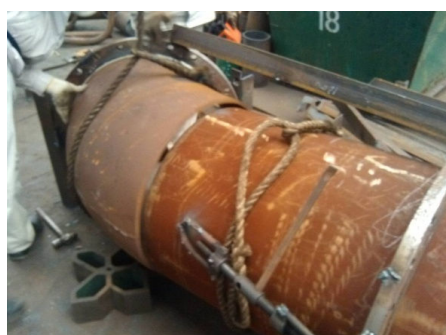
图 2 现场人工放样制作
