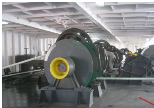
图 2 锚绞机和止链器保护布置
